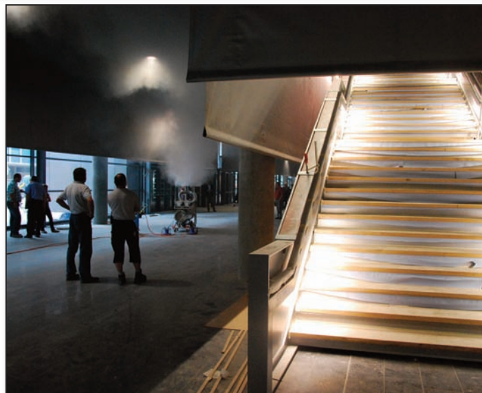
Simulation eines Brandfalles im Foyer Nord mit heruntergefahrenen Rauchschürzen anlässlich der Rauchversuche.
