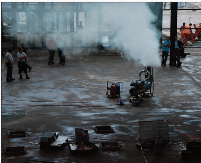
Im Bild: Der Aufbau der Rauchversuche im Portalbereich des Einganges Süd.
